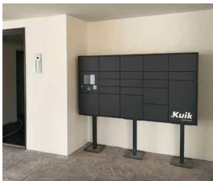
Instalación en exterior cubierto
