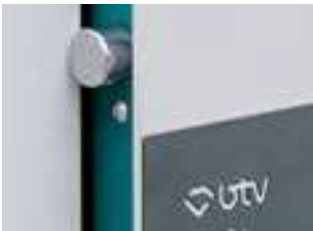
Bulones de Ø25 mm a un lado de la puerta
